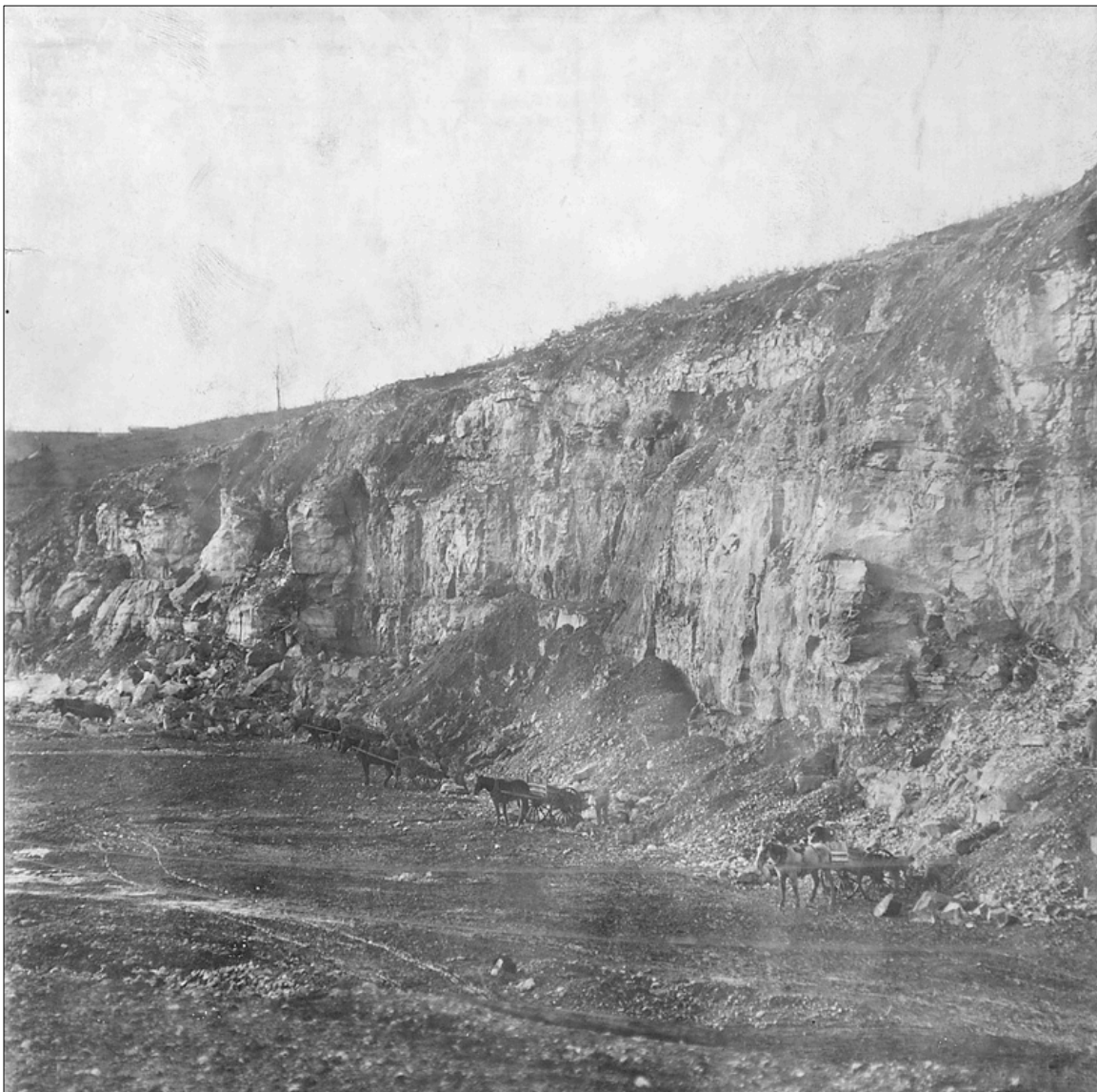
Atelaje la încărcatul pietrei. Foto: arhiva Atlas Portland Cement Co.
