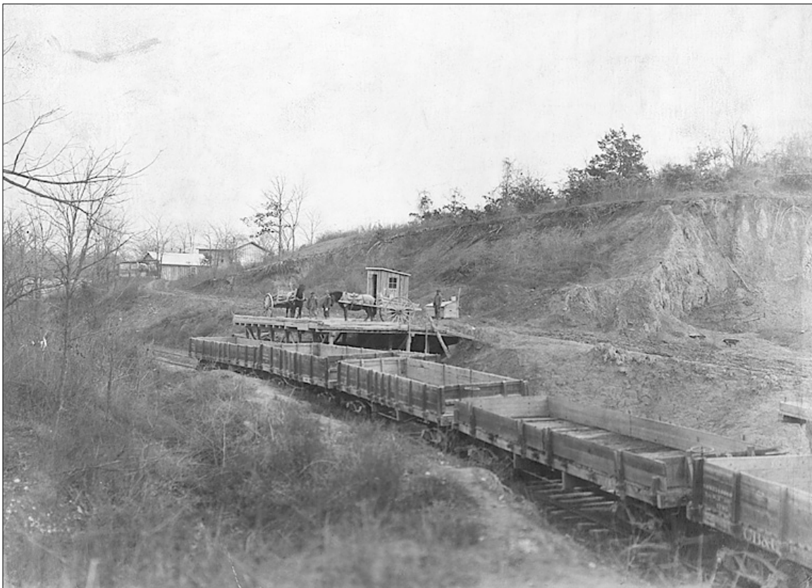
Sus: încărcatul pietrei în atelaje. Jos: rampa pentru descărcare. Foto: arhiva Atlas Portland Cement Co.
